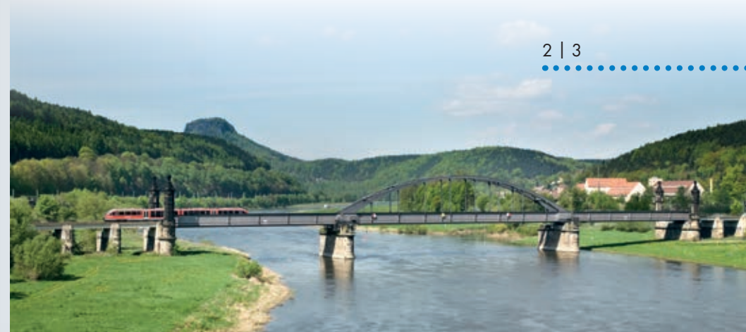
Úz společnosti Deutsche Bahn a.s. na mostě Elbbrücke v Bad Schandau
