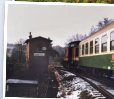
Pohled na Sebnitz s městským viaduktem, kolem roku 1960 Vůz Československých drah u Vilémova, 1992 Odjezd osobního vlaku z Budyšína do Bad Schandau a Sebnitz, 1988 (shora dolů)
